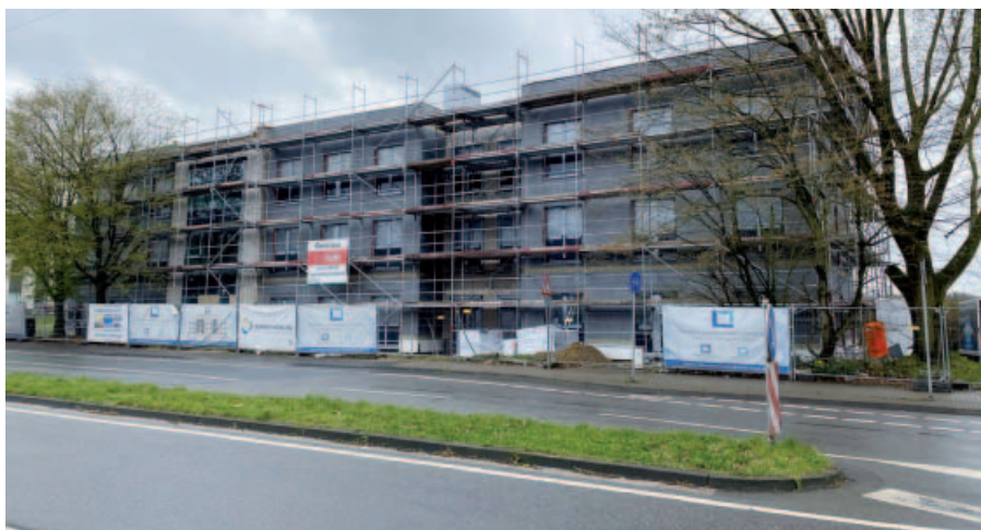
Das zentral gelegene Bürogebäude auf der Amtsgerichtswiese, Bahnhofstraße 67, steht kurz vor der Fertigstellung.
