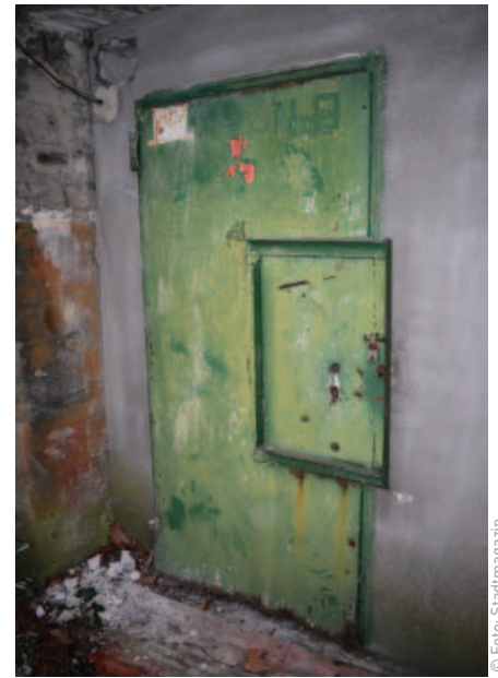
Bunkereingang an der Lange Straße
