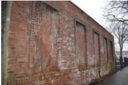
Bunkergebäude an der Lange Straße
