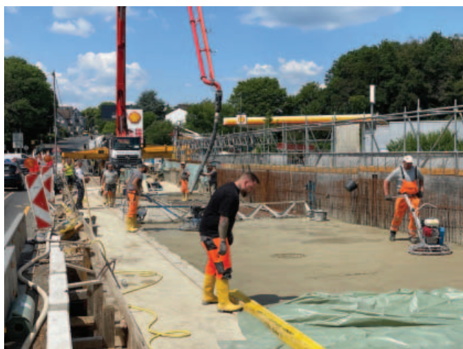
Sanierung Gewölbebrücke A1 Wermelskirchen
