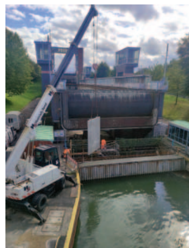
Aktiv direkt vor der Tür: Erstellung Dichtwand Schiffshebewerk Henrichenburg
