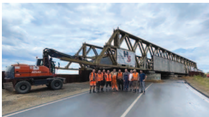
Rückbau der Behelfsbrücke Düren-Gürzenich
